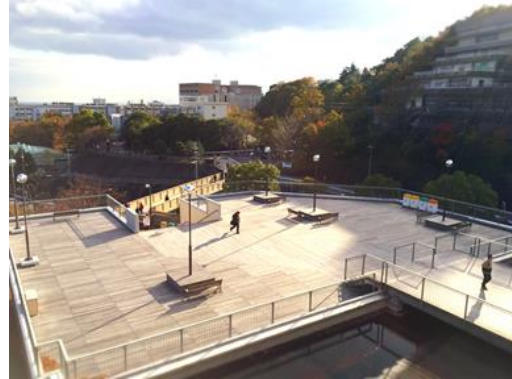
A棟1階 ウッドデッキ
