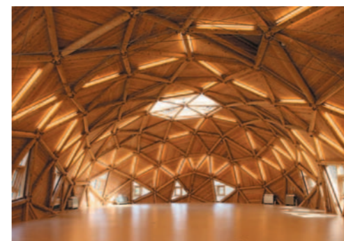
【ひょうご環境体験館】 間伐材を使った3次元トラス構造による空間の創造
