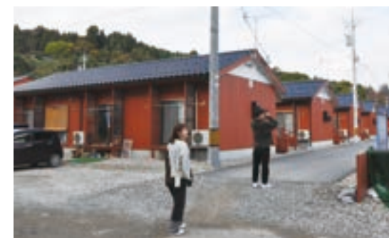
令和6年能登半島地震の木造仮設住宅を調査する学生たち（リスクマネジメント）
