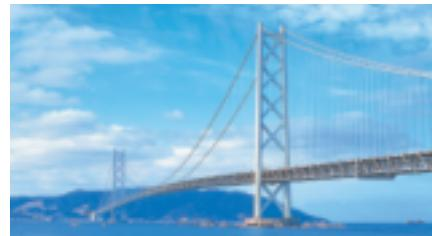
明石海峡大桥。世界上最长的吊桥（全长 3,911 米，主桥墩跨度 1,991 米，主桥墩海拔 297 米，1998 年竣工通车）
