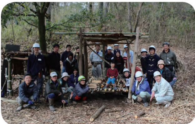
薪小屋の完成!
